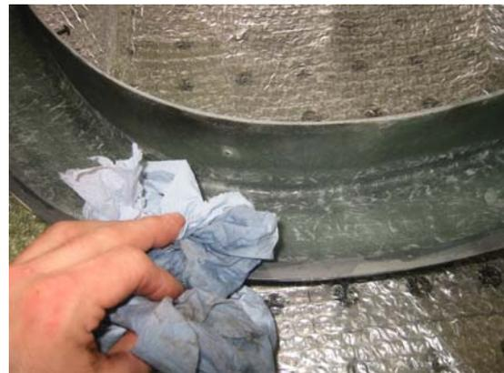
3. Säubern und Entfetten der Klebeflächen an Fahrzeug und Kotflügelverbreiterung
